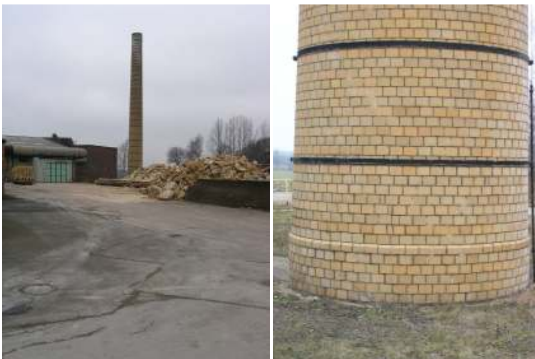
Skrombergas enda kvarvarande skorsten, byggd av tegel som har tillverkats på plats.
