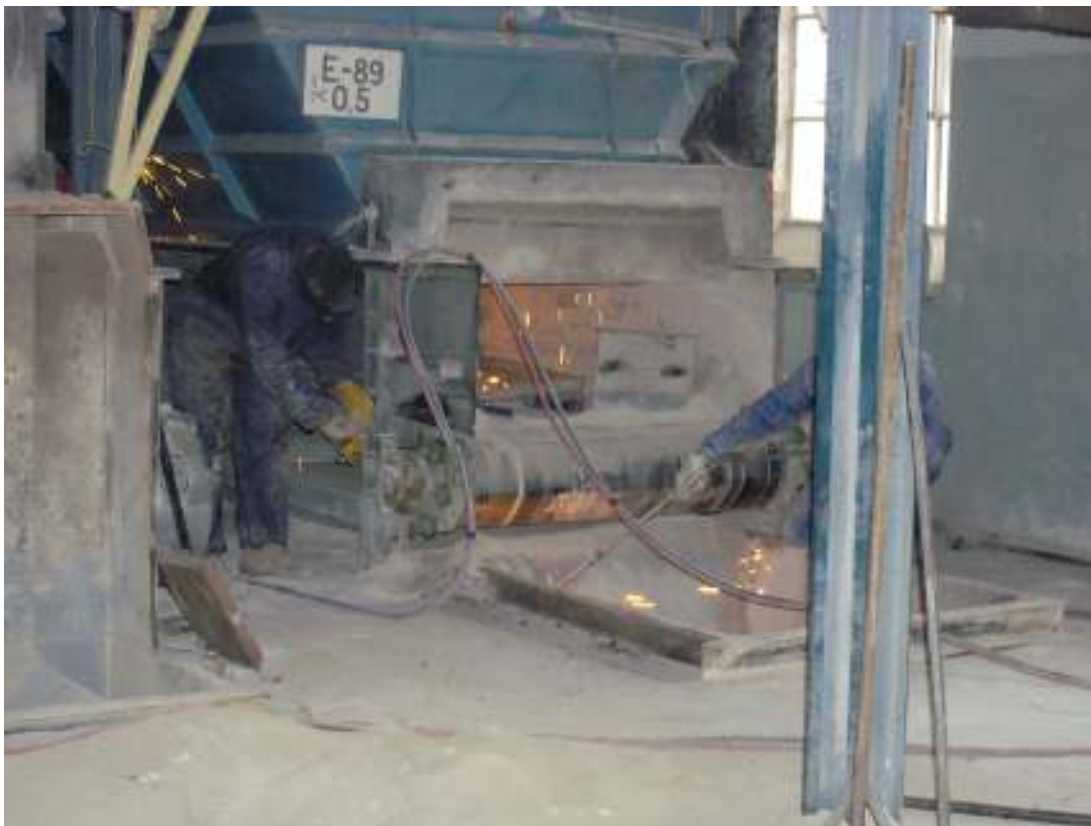
Nedmontering av en lersilo som sedan ska fraktas till Italien för att sättas upp i en fabrik där.
