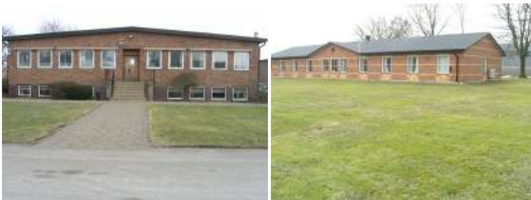
Kontoret från 1945 hyser numera en veterinärmottagning. Ledningen för CC Höganäs sitter istället i denna byggnad.
