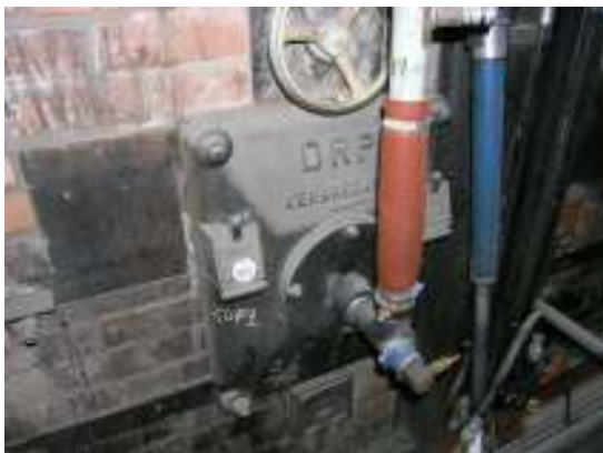
Detalj av den 124 meter långa tunnelugnen.
