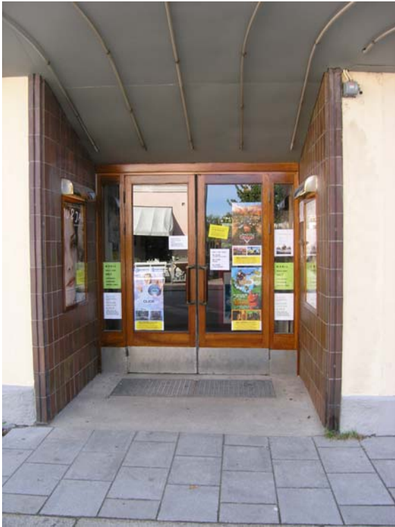
Entréparti efter strykning med Tonkinoise linoljefernissa.
