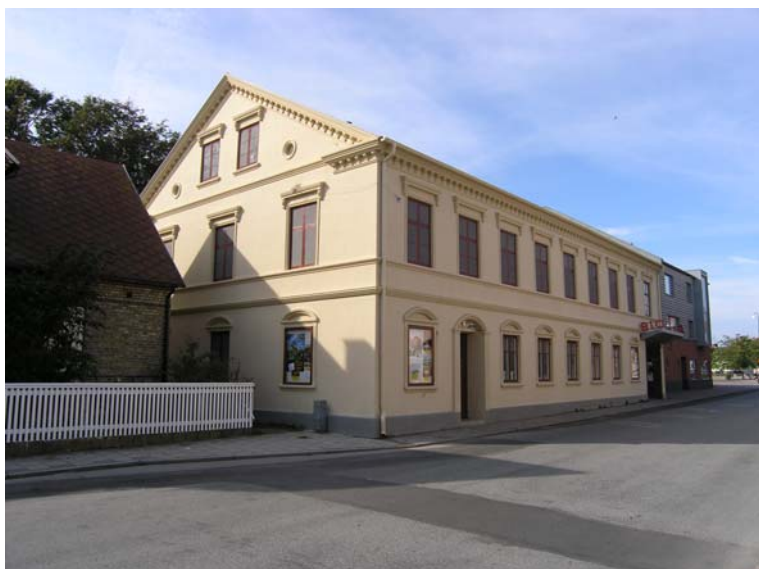
Fasad längs Köpmansgatan och gavel. Blindfönstren och fasader målade, skyltskåpen restaurerade.
