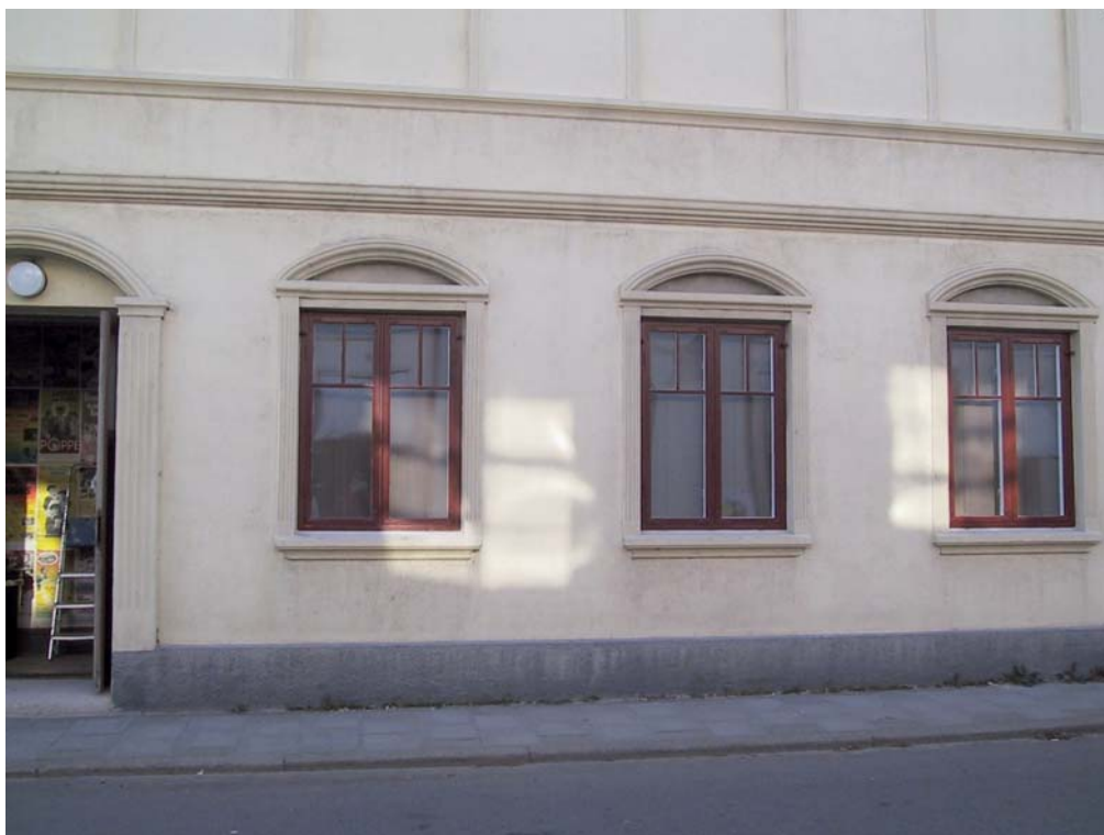
Foto före rekonstruktion av blindfönstren på andra våningen.
