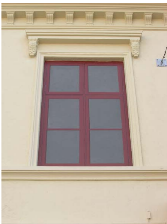
Blindfönster i form av korspostfönster med spröjsning.
