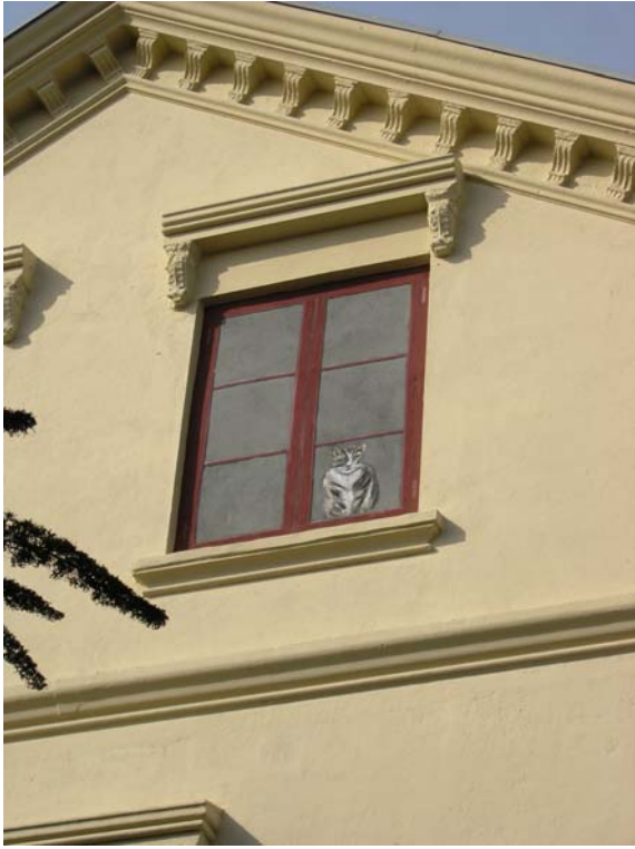
Blindfönster i gavelröset utfördes med silikatfärg.
