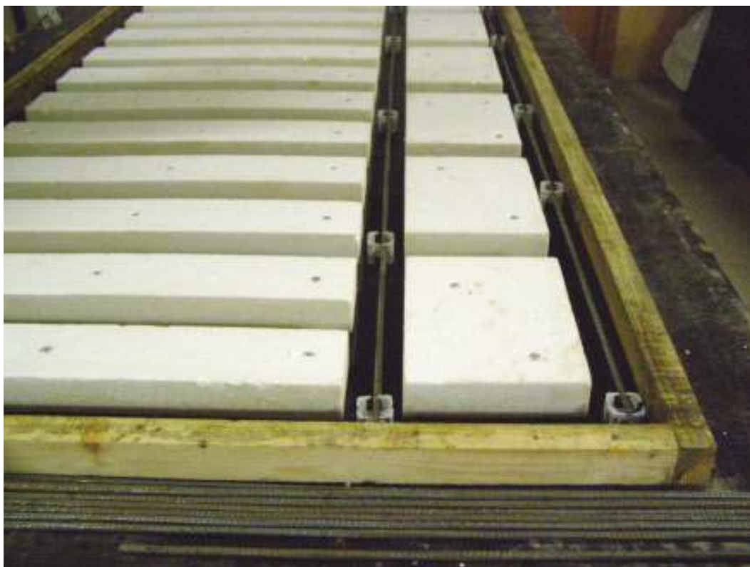
De långa armeringsjärnen läggs ut på armeringsdistanser, 6 st per längd.
