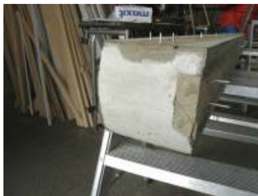
Detalj. Notera avrundningen på stolptoppen.
