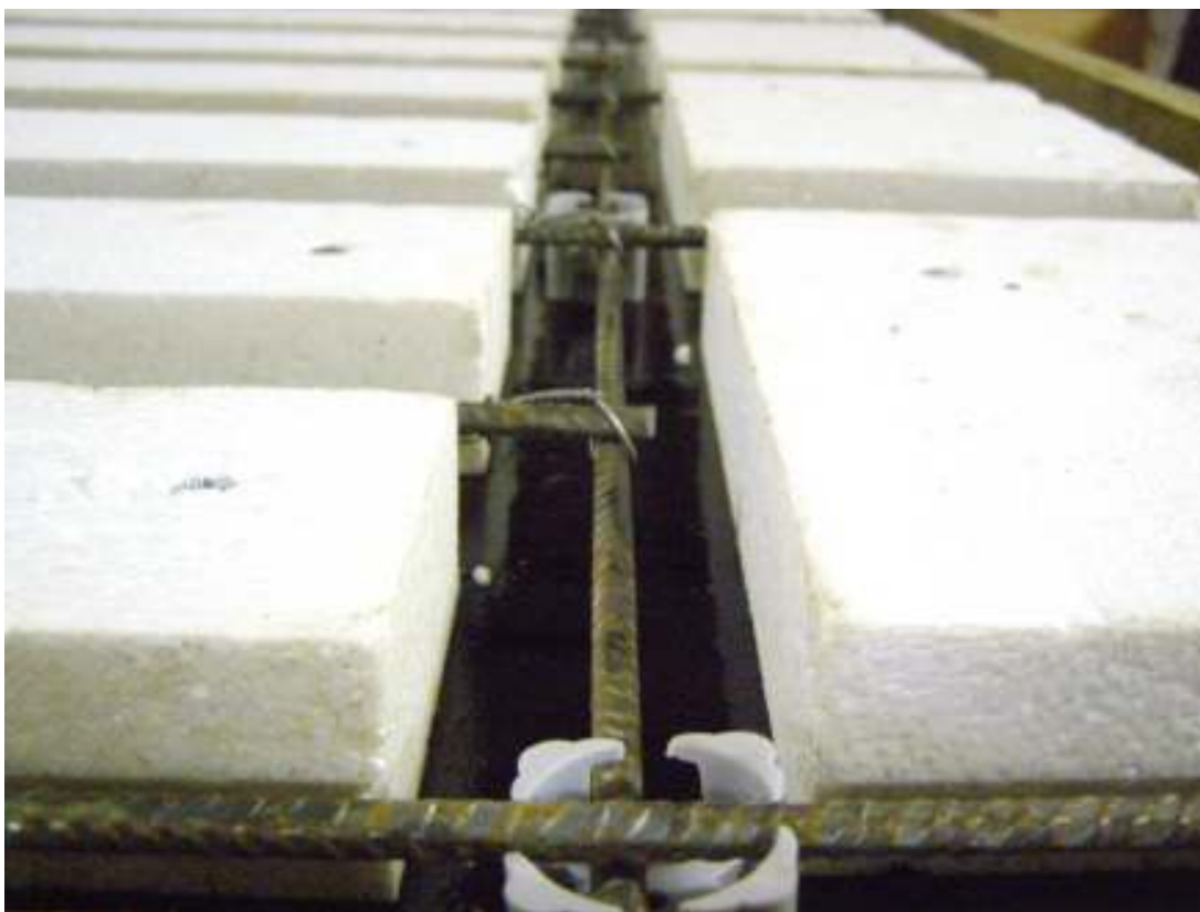
Detalj på armeringen.
