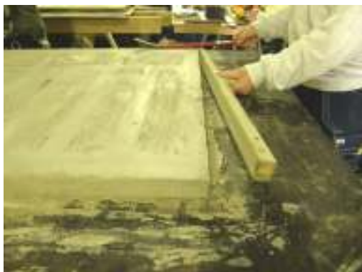
Ytterrampen tas bort.
