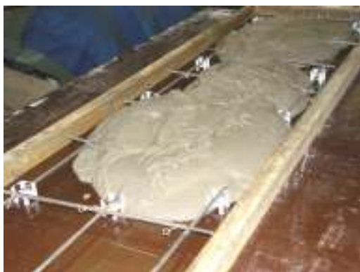
Betongen påförs med t ex en skyffel.
