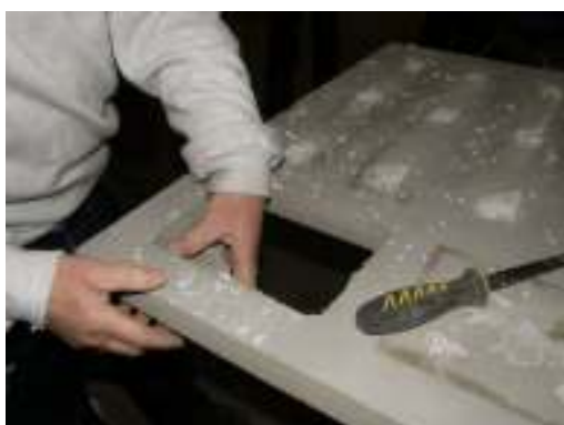
Cellplasten sågas och bryts ur.
