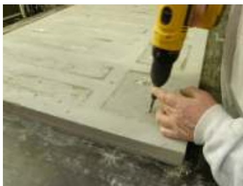
Montageskruvarna tas bort.
